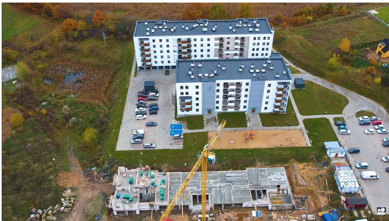
Nowy żłobek miejski na ulicy 1 Maja. Bryła jest już gotowa, rozpoczęto prace wewnątrz obiektu.
