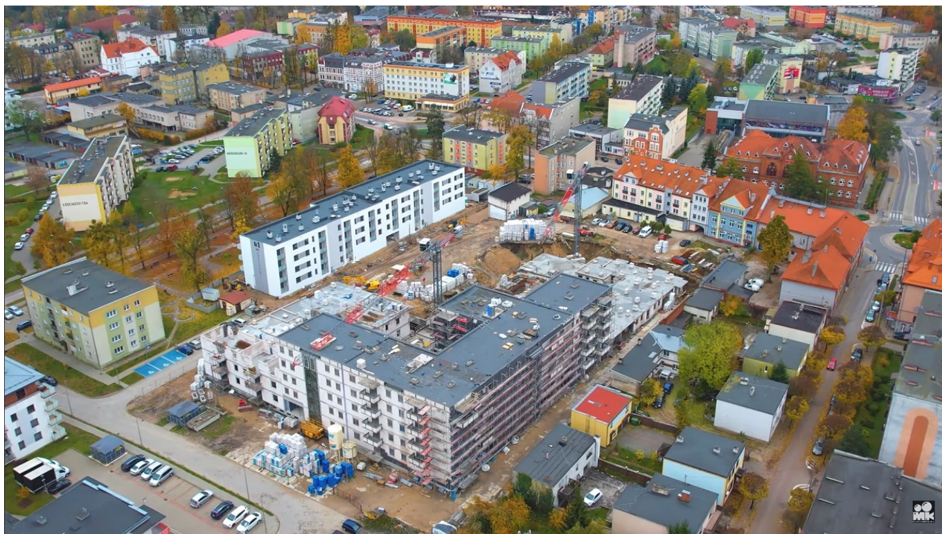
Tutaj, przy ulicy Kościuszki, budowane są nowe wielorodzinne budynki mieszkalne. To dwie odrębne inwestycje różnych spółek.
