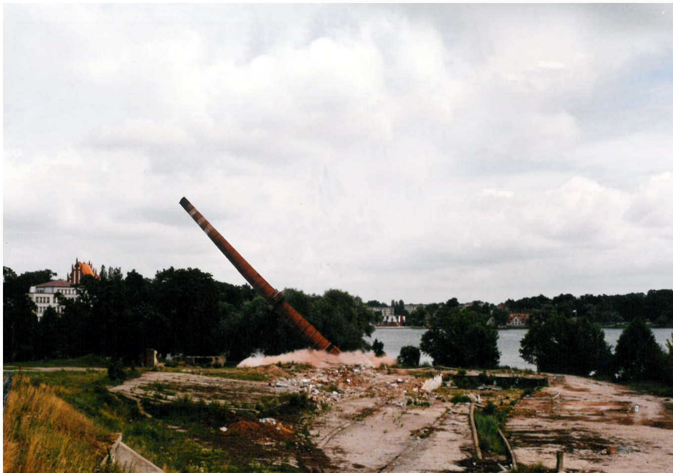
Wyburzanie komina. Koniec ery tartaków nad Jeziorakiem (Fot. Apolinary Szymkowiak)
