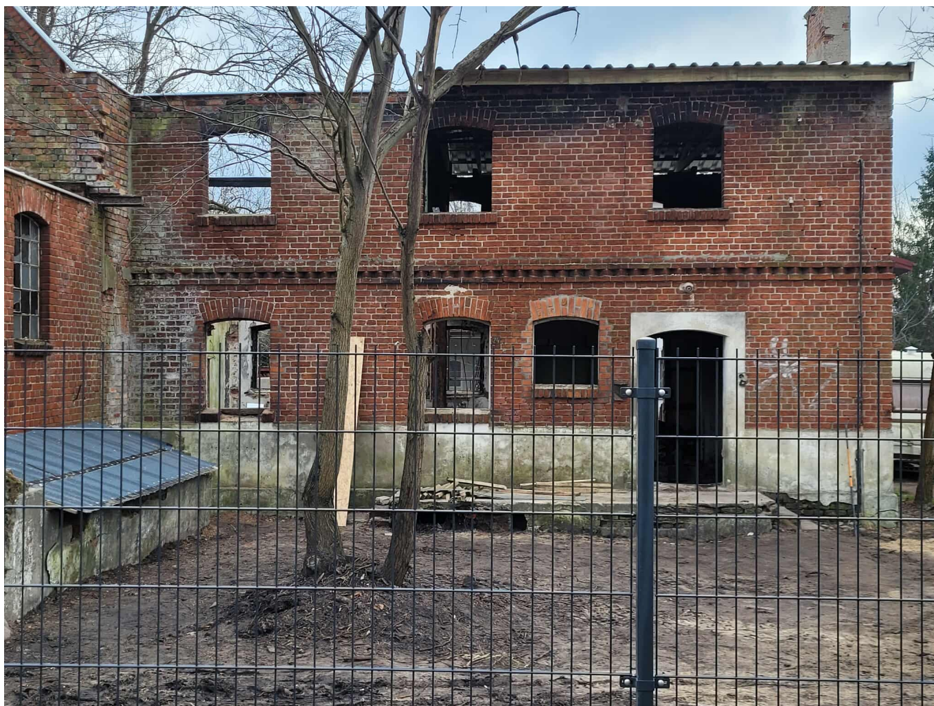
Widok na iławski młyn od strony południowej (fot. arch. Info Iława)
