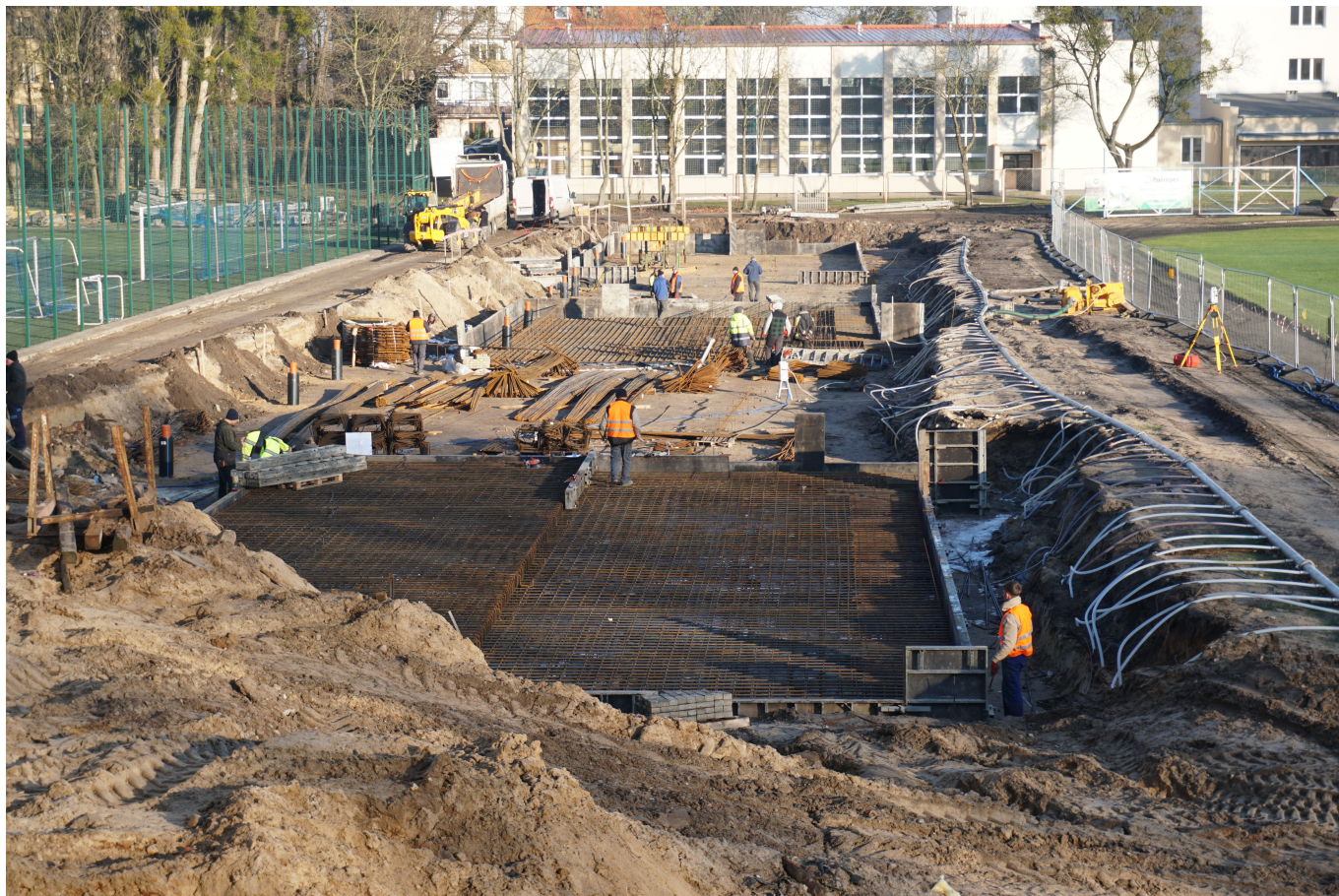
20 stycznia 2025. Tak rozpoczynała się praca nad budową nowej trybuny Stadionu Miejskiego w Iławie (Fot. Mateusz Partyga)
