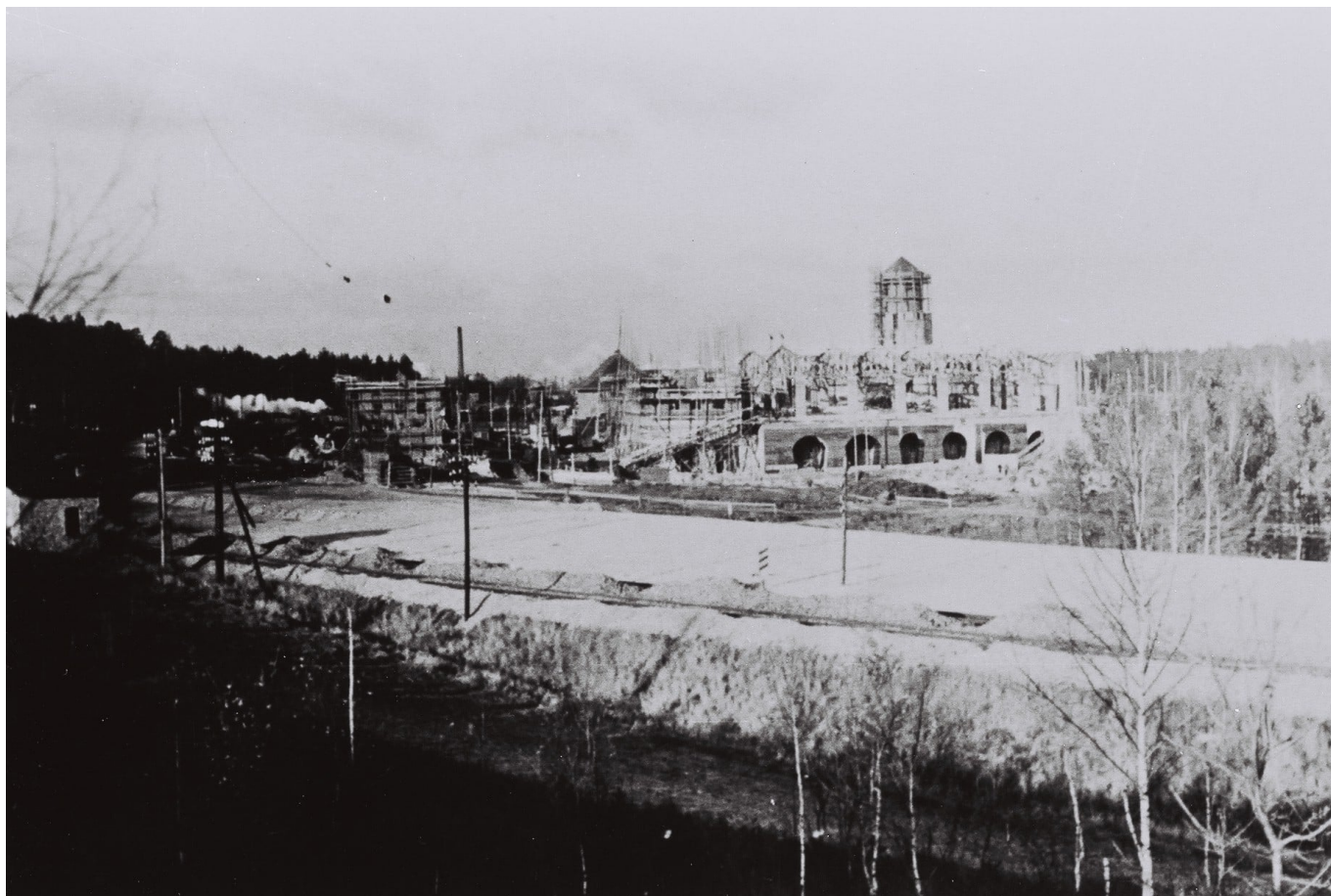
Budowa parowozowni, w tle kolejowa wieża ciśnień (autor zdjęcia nieznany, zbiory Internetowego Muzeum Ławy)
